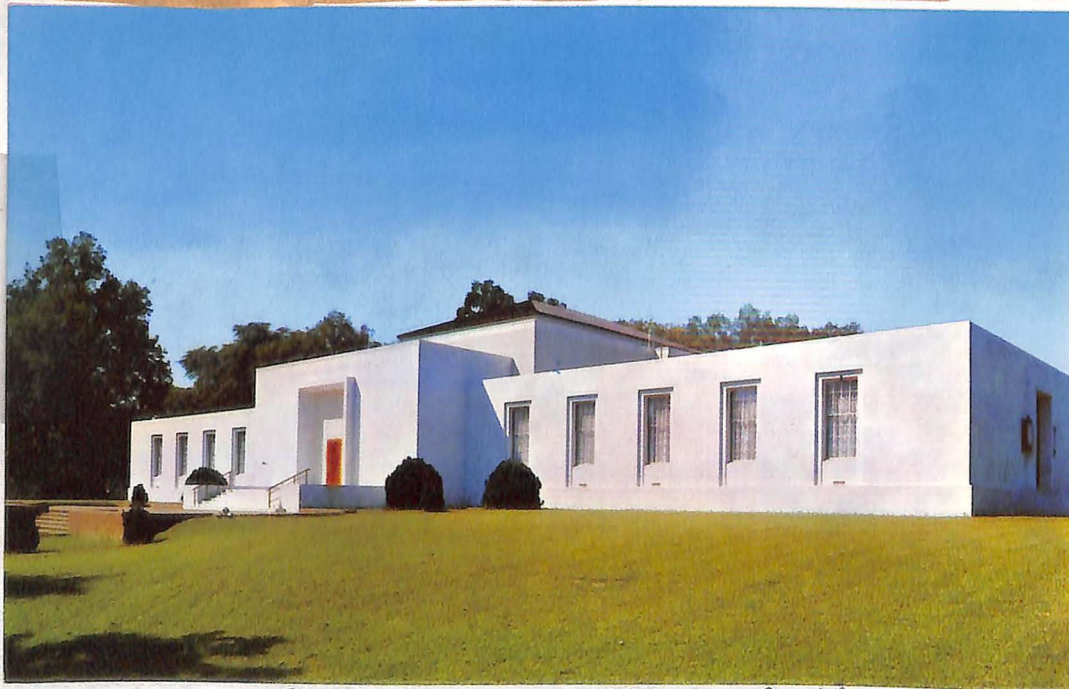
U. D. C. Bldg. North Blvd Richmond VA
